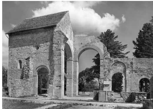
Nordquerhaus nach der Konservierung 1947.
