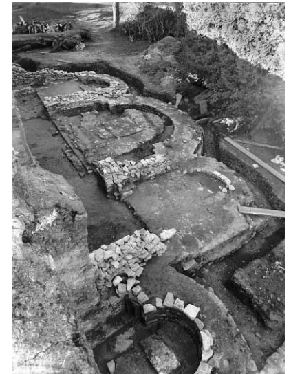
Freilegung der Apsiden, Arbeitsaufnahme von 1940.
